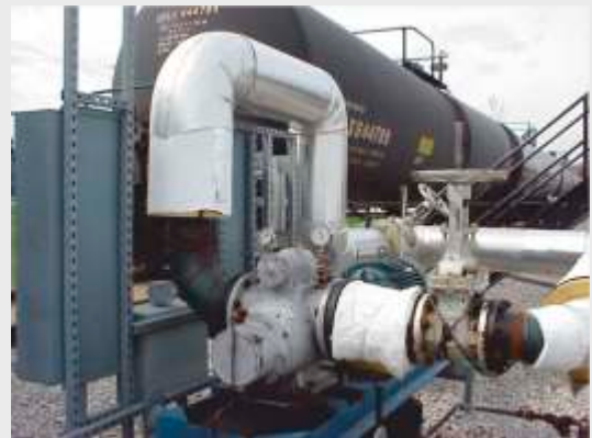
Bomba de tornillos en refinería Asfalto, 120m 3 /h, 10 bar Sistema de Calefacción
